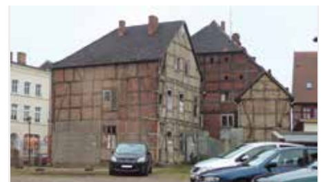
Hofsituation vor der Sanierung
